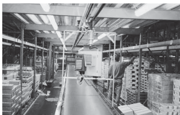
Systém KTW ve výrobním provozu.
